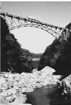
熊本県第一白川橋梁
