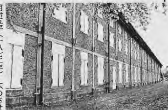
旧官営富岡製糸場 (群馬県富岡市)
