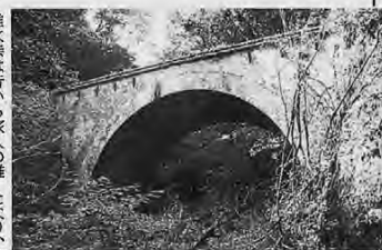
碓氷アプト線遺構 (群馬県松井田町)
