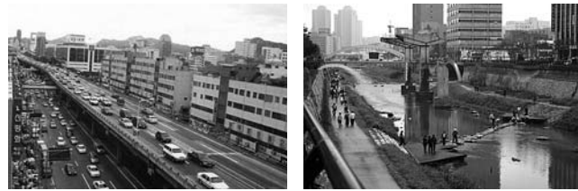
韓国・ソウルの道路撤去と河川・水辺再生
