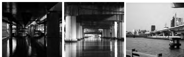
写真6 川を覆う高速道路（左：東京の日本橋川、中：大阪東横堀川、右：河畔の高速道路（隅田川））
