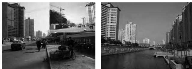
写真5 埋めたれられた高粱河（転河）を再生し、河畔の都市再生を大規模に進めてきた北京（左：再生前、右：再生後。中国）
